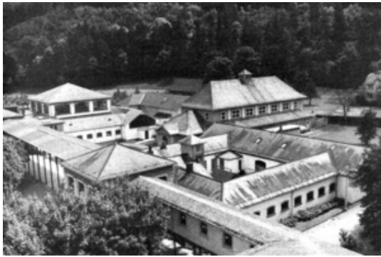
Abb. 3.72: Bad Ragaz, Blick auf Bad und Trinkhallentrakt
