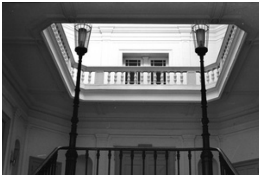
Abb. 3.50: Glarus, Regierungsgebäude, Erdgeschoss, Vestibül
