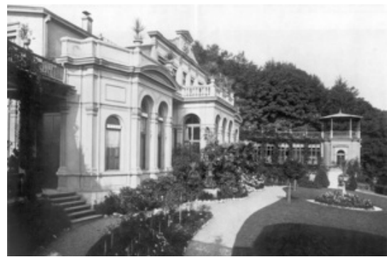
Abb. 3.24: Charlottenfels, ursprüngl. Zustand
