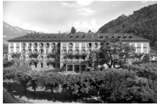
Abb. 3.67: Bad Ragaz, Hotel Quellenhof, nach Ersatz der Roll- durch Klappläden
