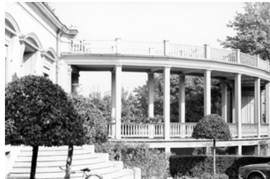
Abb. 3.28: Charlottenfels Galerie, Detail
