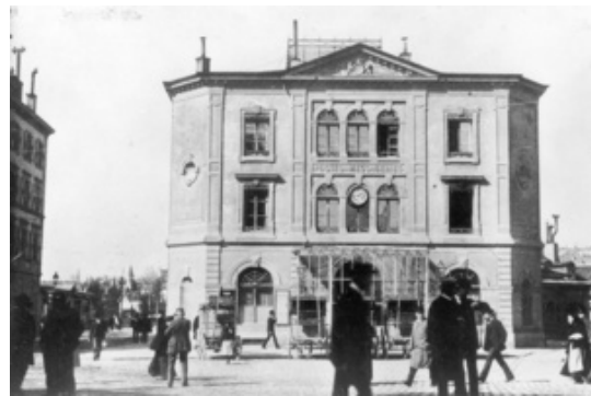
Abb. 3.59: Lausanne, Postgebäude mit späterem Vordach, nach 1865
