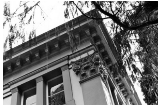
Abb. 3.79: Bad Ragaz, Kursaal, Fassadendetail
