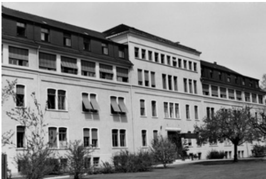
Abb. 3.41: St. Gallen, Gemeindekrankenhaus mit neuem Dachaufbau
