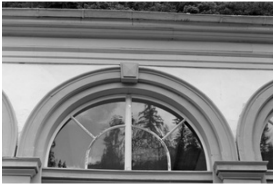
Abb. 3.90: Tarasp, Trinkhalle, Fassadendetail
