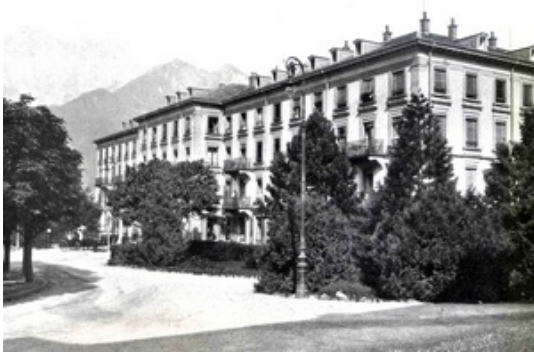
Abb. 3.66: Bad Ragaz, Hotel Quellenhof, ursprüngl. Zustand
