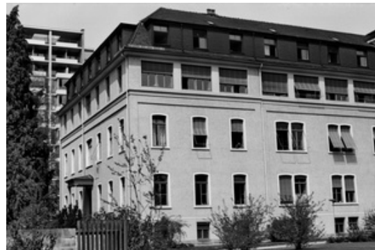
Abb. 3.42: St. Gallen, Gemeindekrankenhaus mit Seitenfassade, heute
