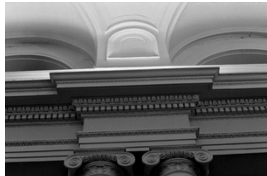
Abb. 3.53: Glarus, Regierungsgebäude, Belétage, Landratssaal, Detail
