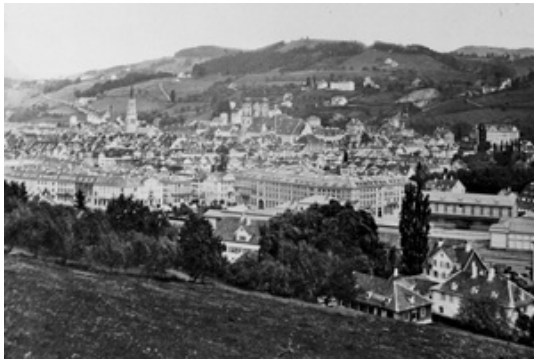
Abb. 3.34: St. Gallen, Postgebäudekomplex heute, vom Rosenberg aus
