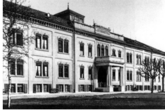
Abb. 3.40: St. Gallen, Gemeindekrankenhaus, ursprüngl. Zustand
