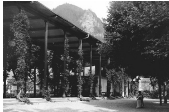
Abb. 3.71: Bad Ragaz, Galerie
