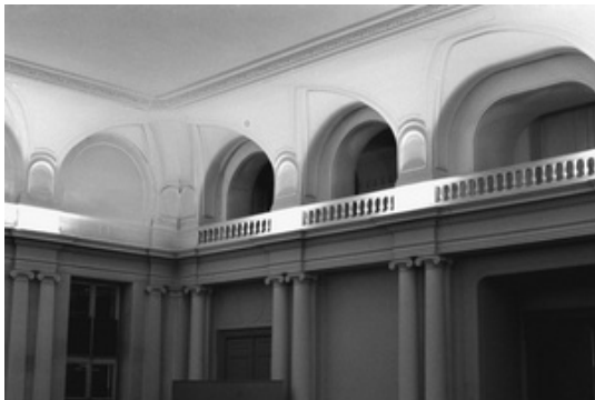
Abb. 3.52: Glarus, Regierungsgebäude, Belétage, Landratssaal, Detail
