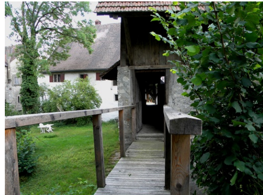
Abb. 22: Scheunennordseite mit Pferdebrücke zur Mühlewiese, im Hintergrund Mühlenordseite.
