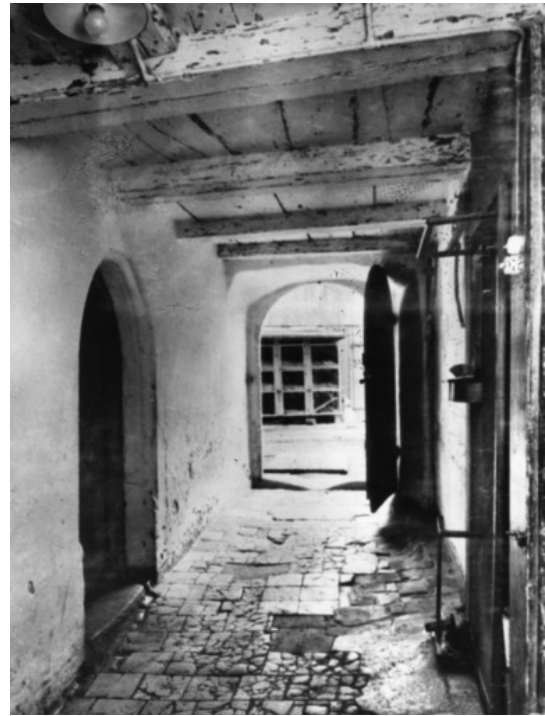
Abb. 13: Eingangskorridor zu Küche, Mahlraum und Stube vor seinem Umbau 1968.
