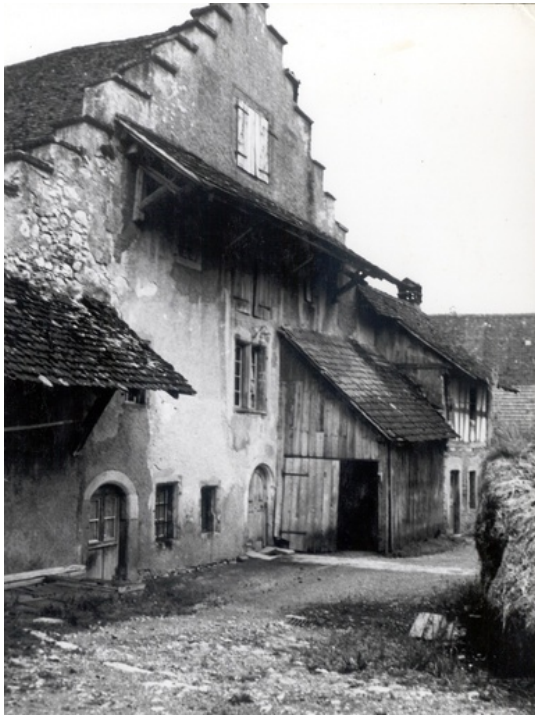
Abb. 12: Zustand der Mühle vor der Restaurierung.
