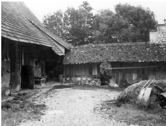
Abb. 17: Einseitig verschlossener Verbindungsgang zwischen Mühle und Scheune, vor 1968
