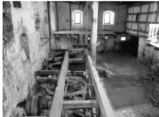
Abb. 16: Blick gegen Ostmauer mit Mahlstuhl des 20. Jh. Rechts oben Reste der Estrade, 1968.
