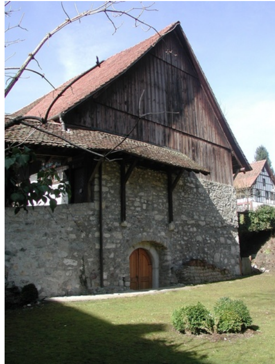
Abb. 24: Ostseite der Scheune nach Abbruch der Trotte. Freier Blick auf das Rundbogenportal zum Weinkeller.
