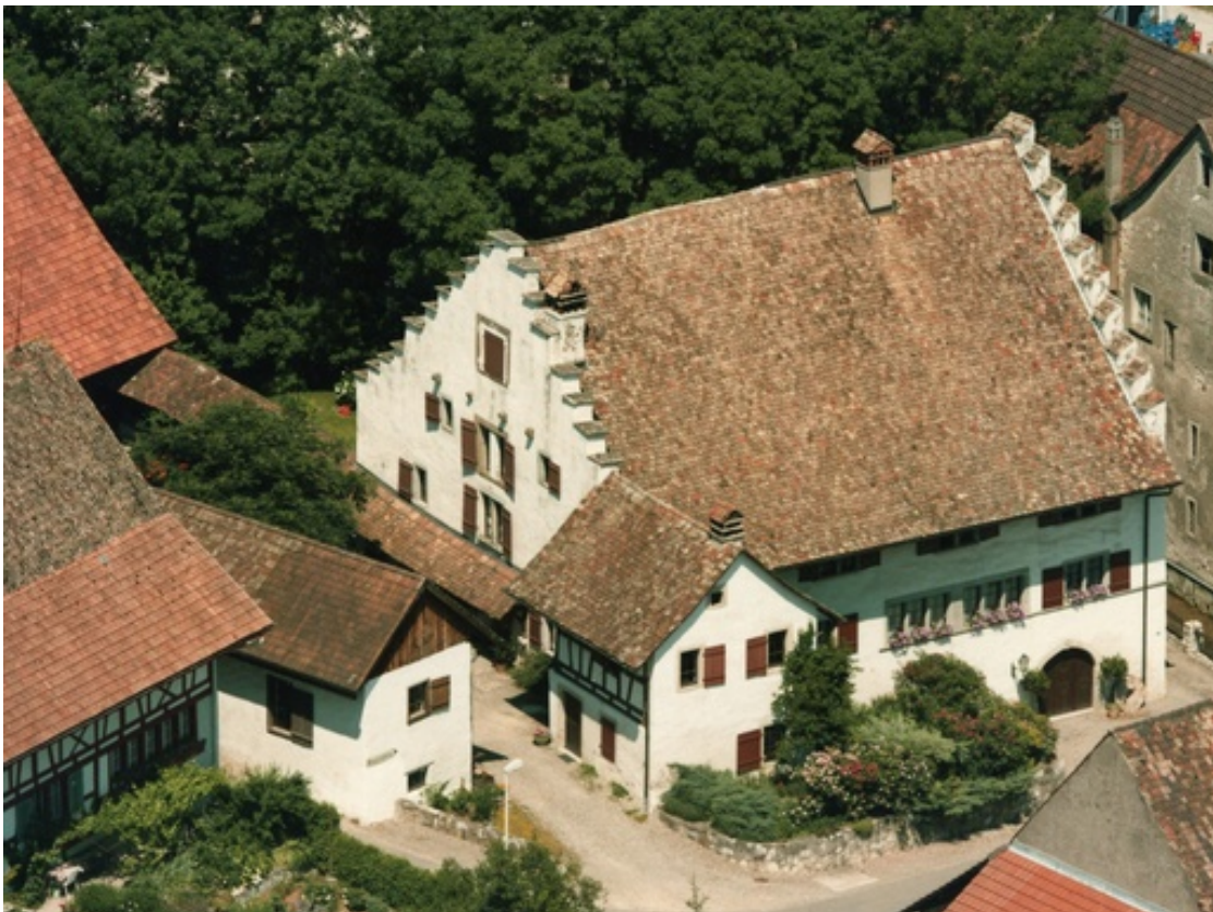
Abb. 25: Gesamtanlage mit dem massigen Block der Mühle mit angebautem Waschhaus und den mit Verbindungsgang, Scheune und ehemaligem Schweinestall hofbildenden Nebengebäuden, nach 1968.
