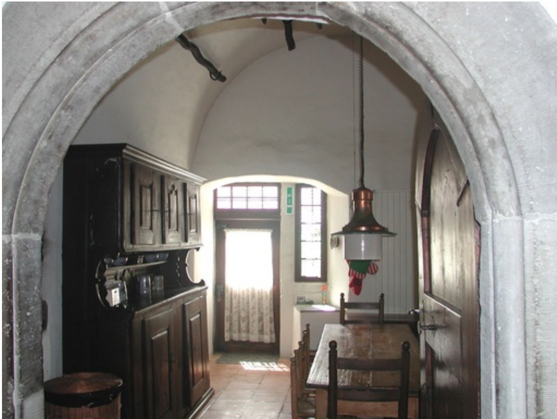
Abb. 33: Ehemalige Rauchküche mit Portalrahmen aus Sandstein.
