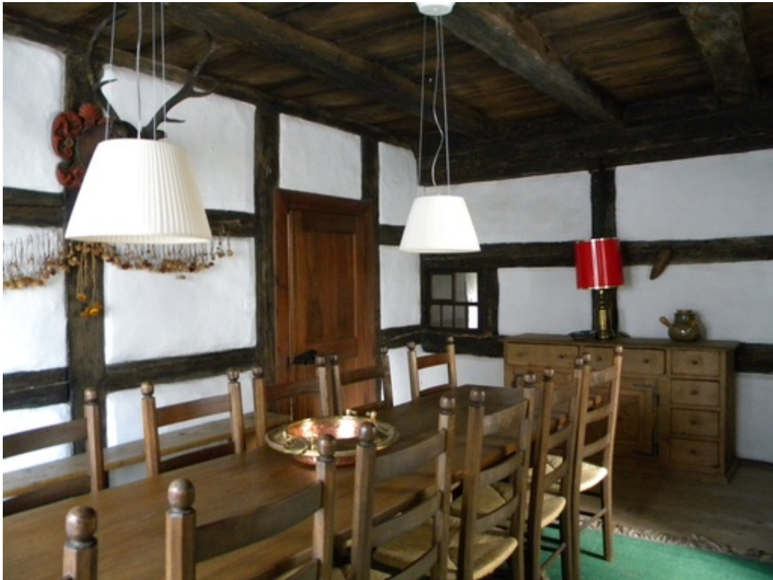
Abb. 32: Müllers Raum mit Binnenriegel und Guckfenster zum Mahlraum.
